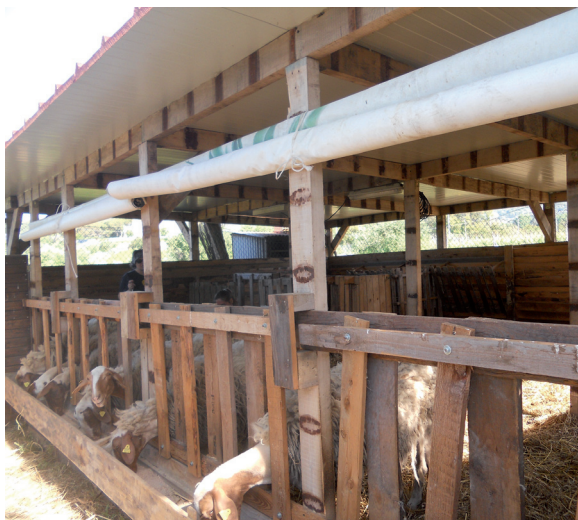
Ovile sano e funzionale costruito con materiali di recupero (allevamento di Sara Esposito, Isola d'Elba)
